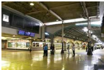
以前のボートレース鳴門。老朽化は進んでいたがそれはそれで風情があった
